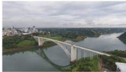
Ponte Internacional da Amizade (BR/PY)
